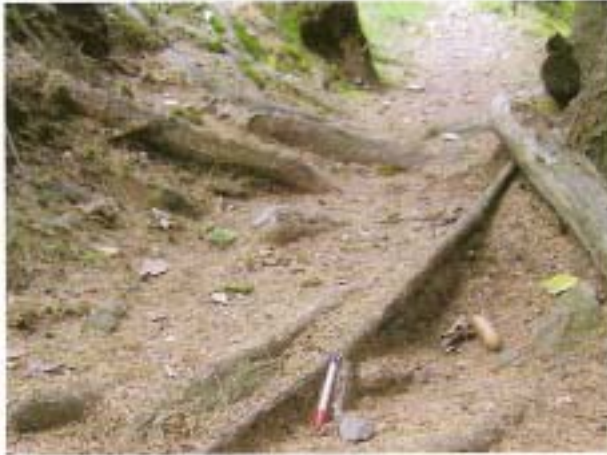
Abb. 25: Starke Wurzelbildung kann zu einer starken Verschlechterung der Nutzbarkeit führen.
