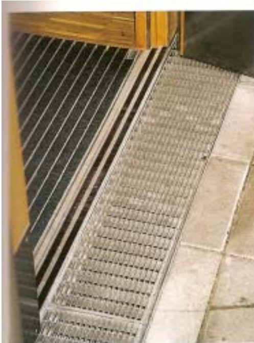
Abb. 5-62: Zugang mit Drainrost und Magnetschiene; für Rollstuhlnutzer gut geeignet
