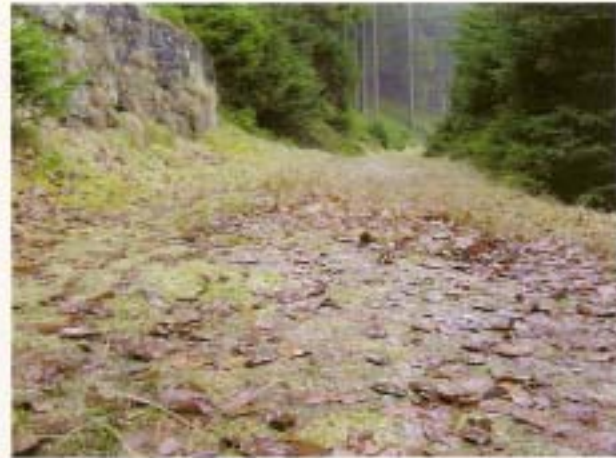
Abb. 24: Gefahr des Verkrautens bei wassergebundenen Decken. Bei Nässe wird dadurch die Nutzung erheblich erschwert.
