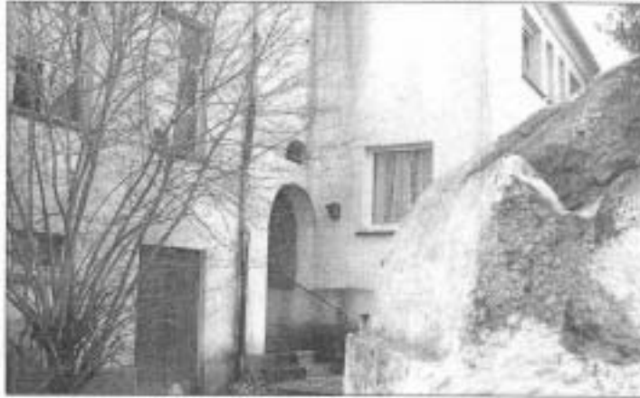
Leer stehende, vom Verfall bedrohte Häuser: Das droht vielen Dörfern, wenn das Umsiedlungskonzept anläuft. FOTO: FORBERT
