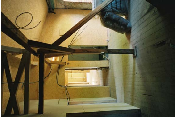
Umbau Eingerichtete Gäste-Etage
